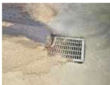
【○】排水施設の敷設
