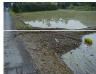
圃場出入り口の斜面が削れ丸くなっていると車輪が浮きとても危険だ
